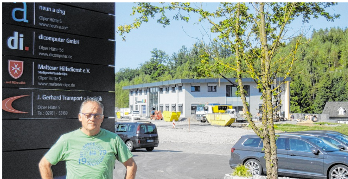
Christof Gerhard macht die Olper Hütte 5 zum Standort eines Gewerbeparks. Zahlreiche Firmen konnten bereits angesiedelt werden, Platz für weitere wird in Neubauten geschaffen.
