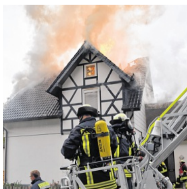
Die Ursache für den Dachstuhlbrand in Attendorf ist noch unklar. FOTO: STEINBACH
