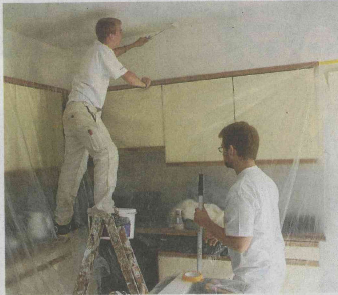
Die Jungs vom CJD arbeiten neben anderen unermüdlich an der Renovierung der alten Vikarie, um den syrischen Flüchtlingsfamilien ein attraktives Heim zu schaffen.
